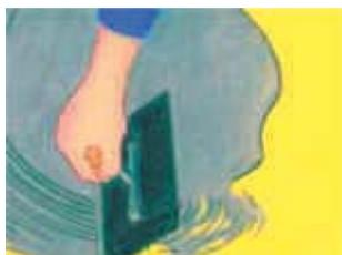
Rivestimento del pavimento con Körapur 689
